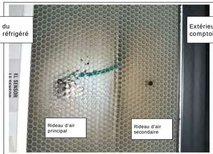
Capteur d'air d'évacuation vu à travers le nid d'abeilles d'évacuation
