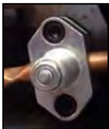
Vanne de piquage de conduite de réfrigération
