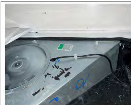
Correcto - el sello está entre la parte inferior del panel posterior y la parte superior del pleno de ventiladores
