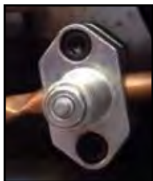
Vanne de piquage de conduite de réfrigération
