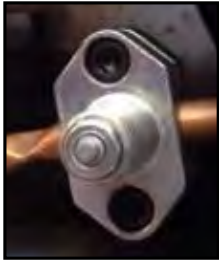
válvula de toma de la línea de refrigeración
