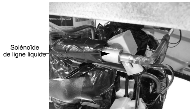
Figure 49. Solénoïde de ligne liquide (1 par barillet)
