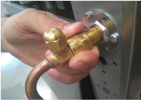
Image 4: Filetez les raccords à la main
