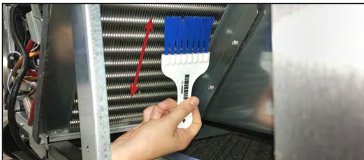
Fig. 3. Nunca pase el cepillo en perpendicular a las aletas del serpentín.
