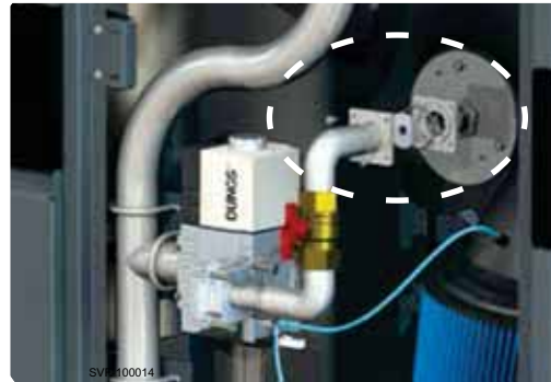
Figure 6 Emplacement de l'orifice du gaz propane
